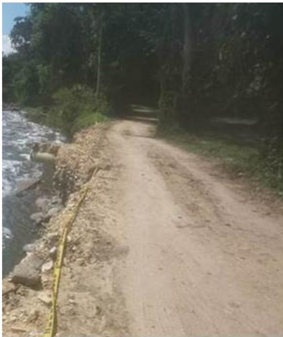
Fotografía 3. Vista de la vía veredal afectada por el proceso de socavación marginal.
