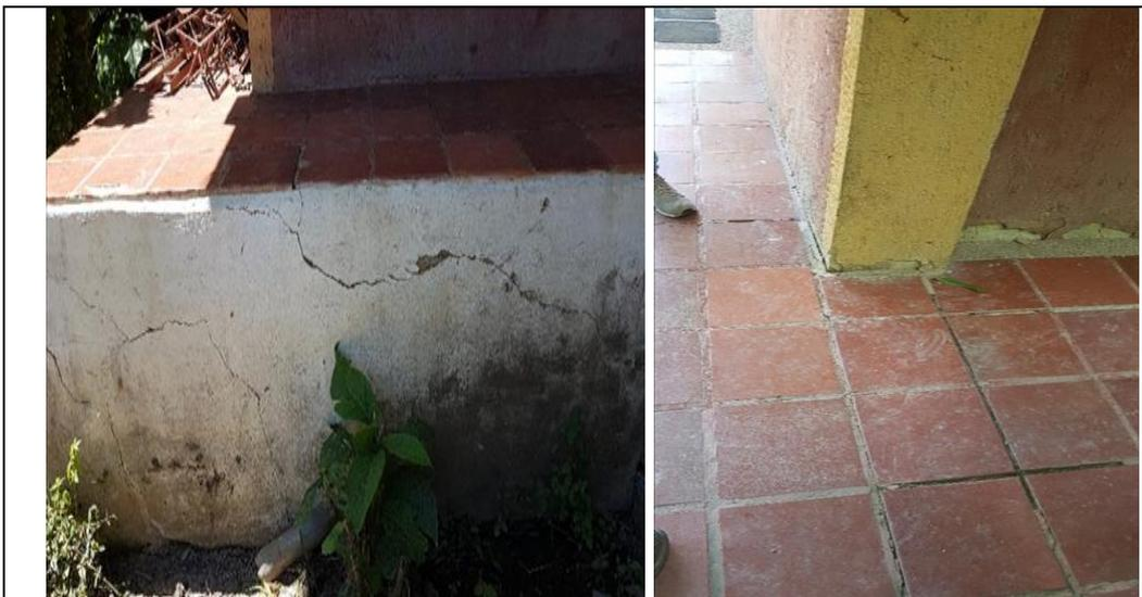
Fotos 3 y 4. Cimentación de la vivienda con fisuras y grietas
