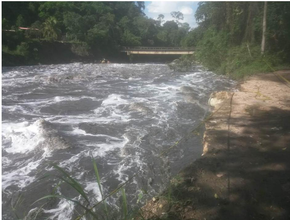
Fotografía 1. Vista de la socavación marginal derecha, pérdida de parte de la vía veredal
