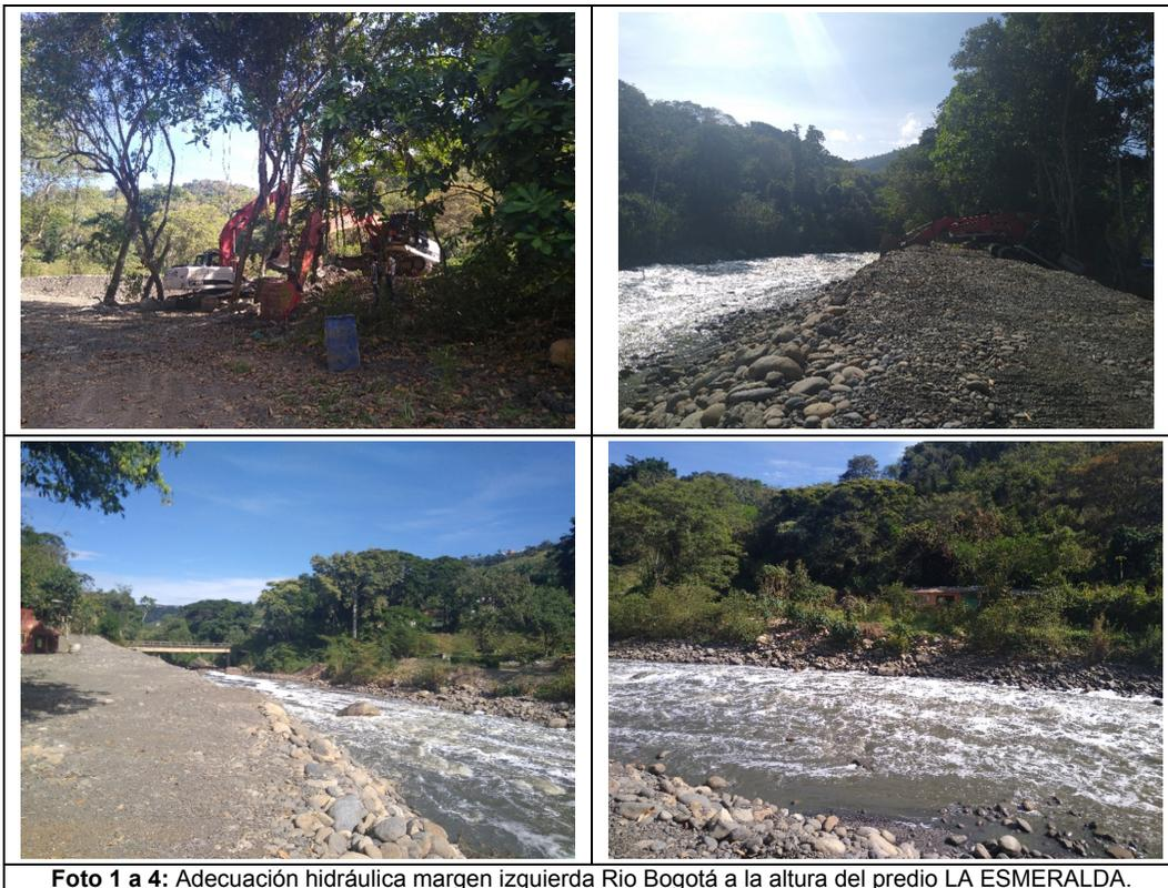
**Foto 1 a 4:** Adecuación hidráulica margen izquierda Río Bogotá a la altura del predio LA ESMERALDA.
