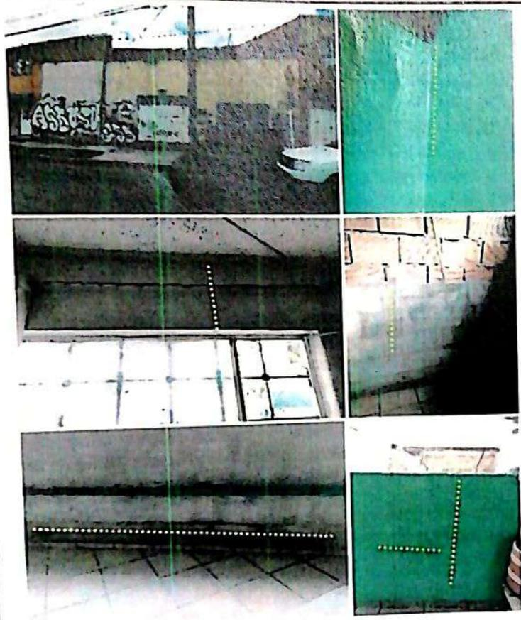
Corresponde a un inmueble de uso residencial de un nivel y terraza, construido posiblemente bajo un sistema estructural de mampostería parcialmente confinada, con placa en concreto y un sector con cubierta liviana de tejas en fibrocemento.
