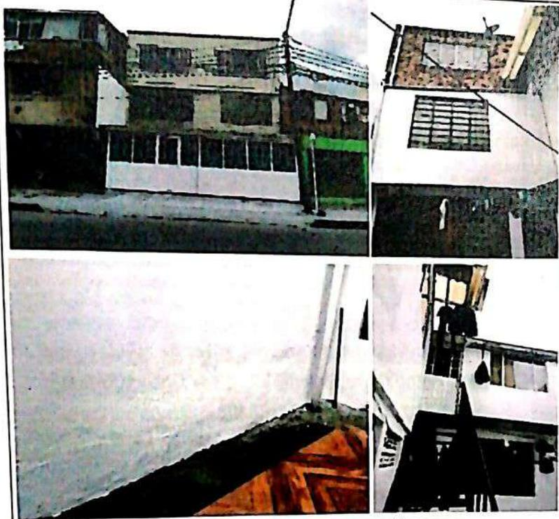
Corresponde una vivienda de uso residencial de tres niveles en el costado suroriental y 2 niveles en el costado noroccidental; construido posiblemente bajo un sistema estructural de mampostería parcialmente confinada y cubierta liviana de teja de fibrocemento y plástico apoyada en perfiles metálicos y muros de la edificación.
