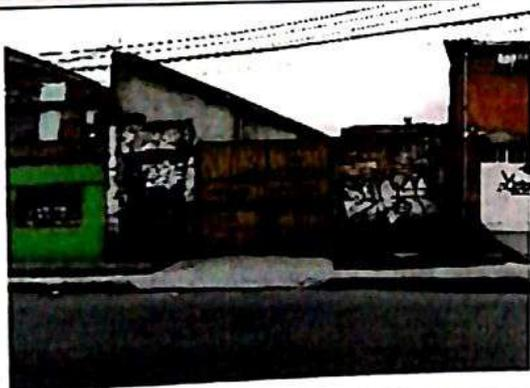
No fue posible el ingreso al predio. Sin embargo, la inspección visual desde el exterior permite evidenciar un muro en mampostería simple, construido con dos tipos de bloque, presentando fisuras en el cambio de material.
