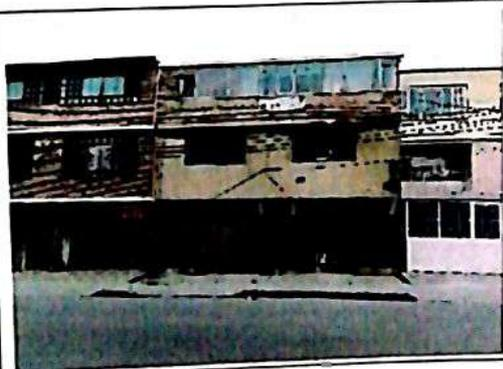
Corresponde a una vivienda de tres niveles construida posiblemente bajo un sistema estructural de mampostería parcialmente confinada y cubierta liviana de teja de plástico apoyada sobre perfiles metálicos y muros de la edificación.
