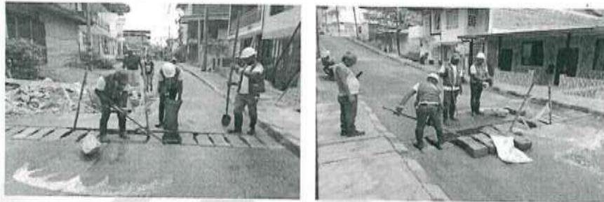
Estado actual de canal de aguas lluvias y residuales el cual se encuentra obstruido por un predio del sector, este ingresa a una tubería de 20" de diámetro aproximadamente, este cuenta con malla para retener los residuos
