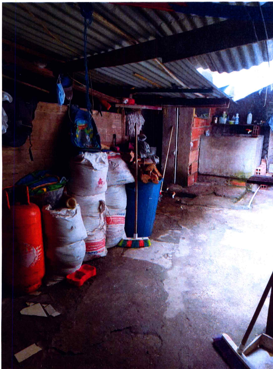
FOTO No 4. PATIO Y TANQUE LAVADERO
