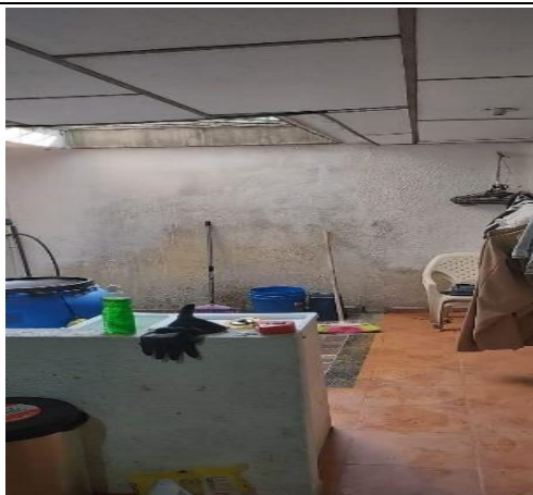
ZONA DE LAVADO
