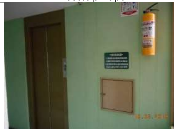
Ascensor en el piso 5
