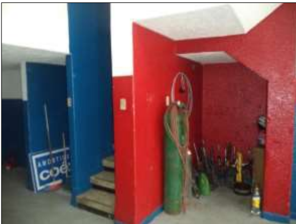
ESCALERAS DE ACCESO AL MEZZAN
