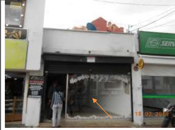
Fachada del Local
