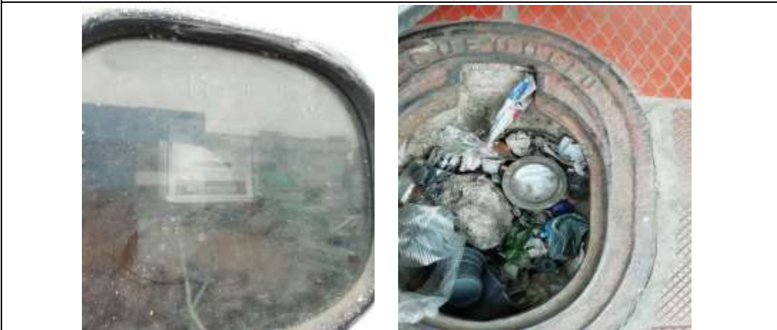
ACOMETIDAS Y CONTADORES DE SERVICIO PUBLICO
