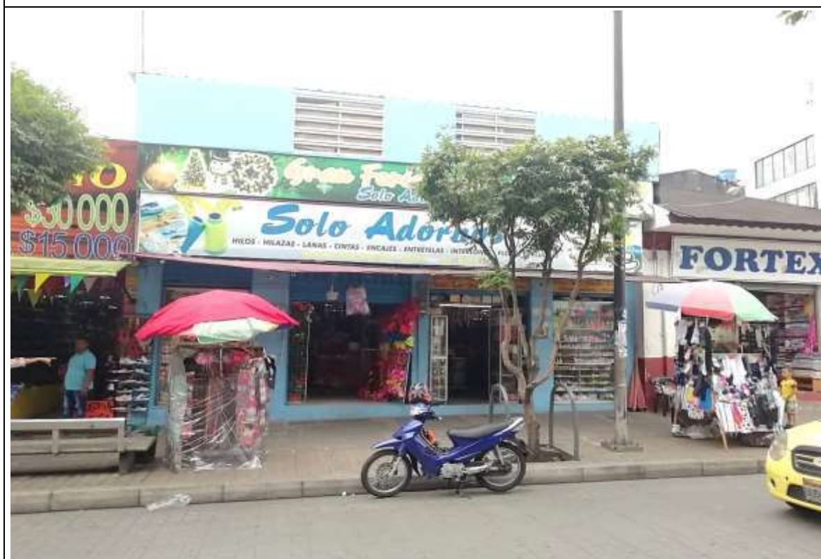
PORTADA DE INGRESO AL PREDIO
