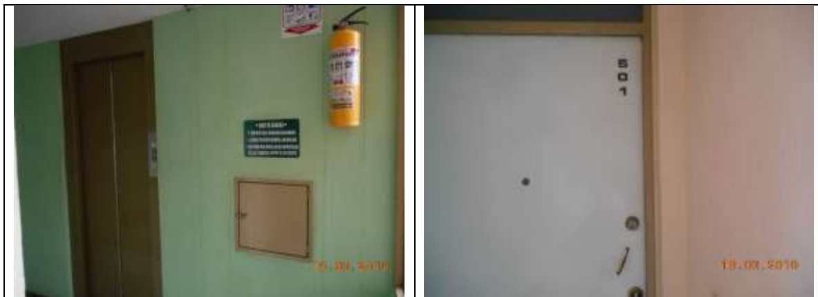
Hall y ascensor en el piso 5
