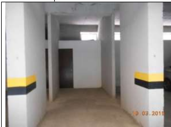
Parqueadero tipo en sótano
