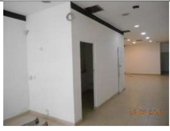
Depósito y baño
