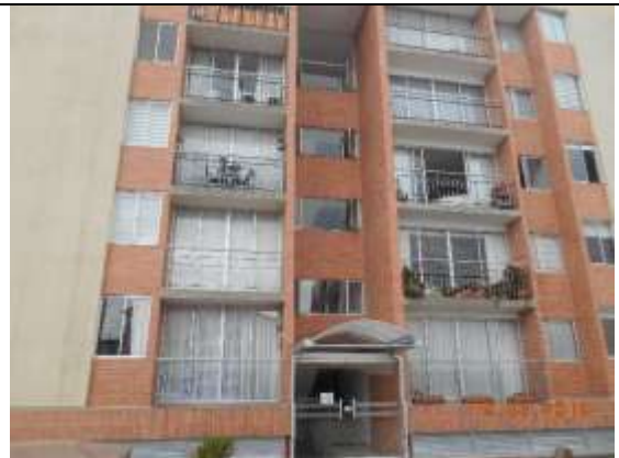
Acceso a la torre 2
