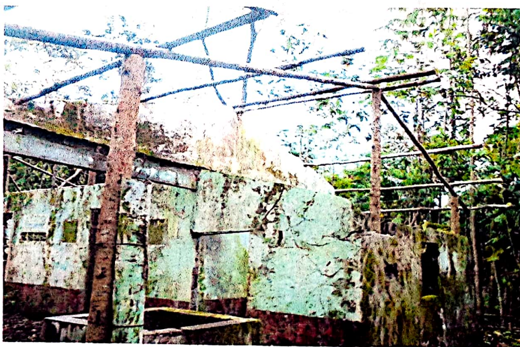
Imagen No. 04: Se aprecia la intervención (reconstrucción) de la casa de habitación y mejoras, hechas por el Demandante.
