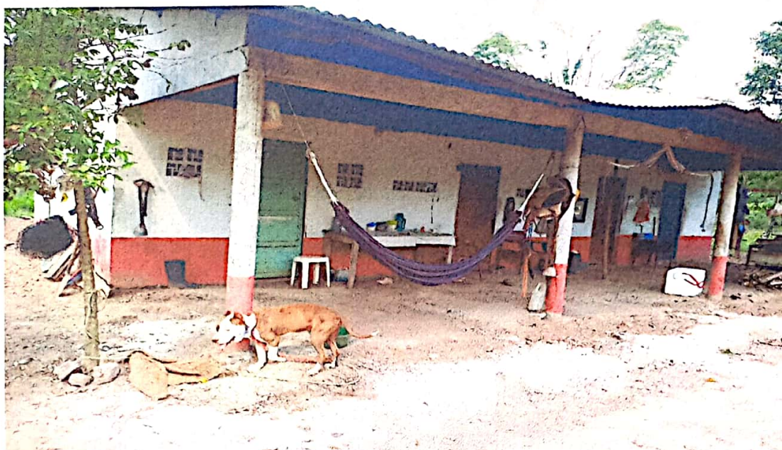
IMAGEN No. 07 – Se aprecia la RECONSTRUCCION de la Vivienda, despues de más de 20 años de Abandono, cumpliendo el Objeto Social de los Bienes Inmuebles.
