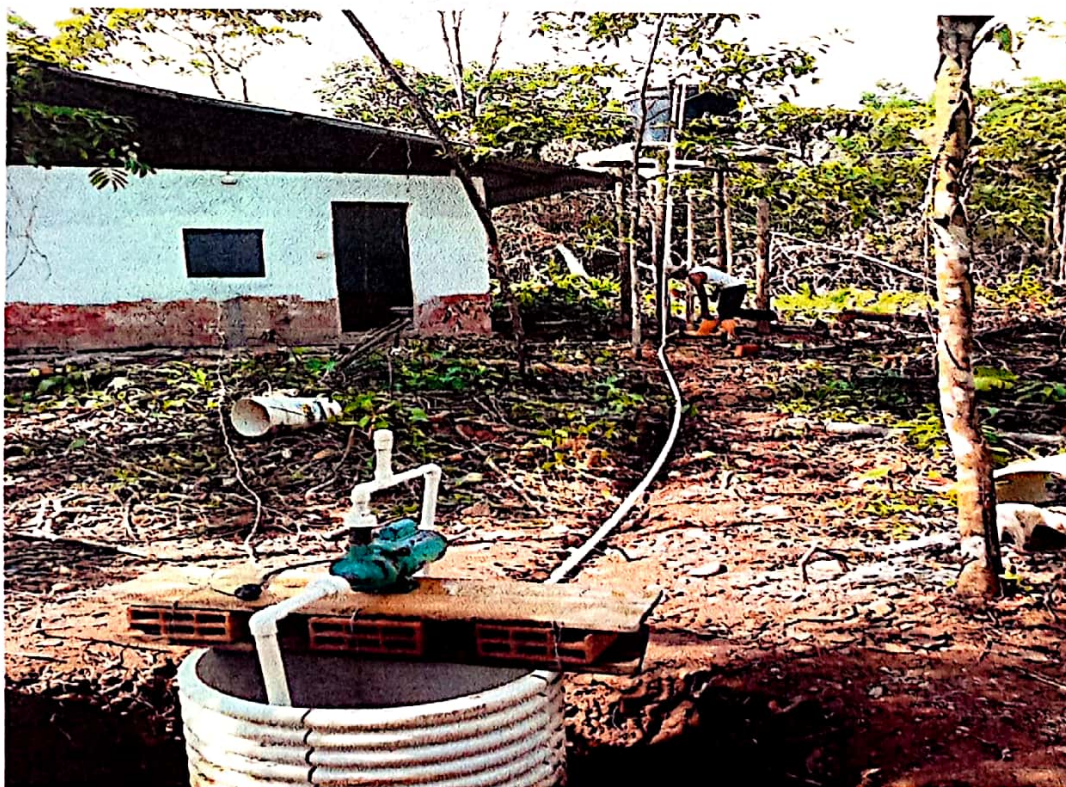
Imagen No. 06: Se evidencia la construcción del Jagüey, instalación de Agua con tanque elevado, sistema de luz con Planta eléctrica, y reconstrucción total de la Vivienda, con todos los servicios.
