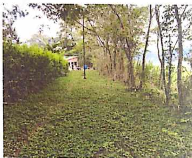
Dique longitudinal (Obra nueva)
