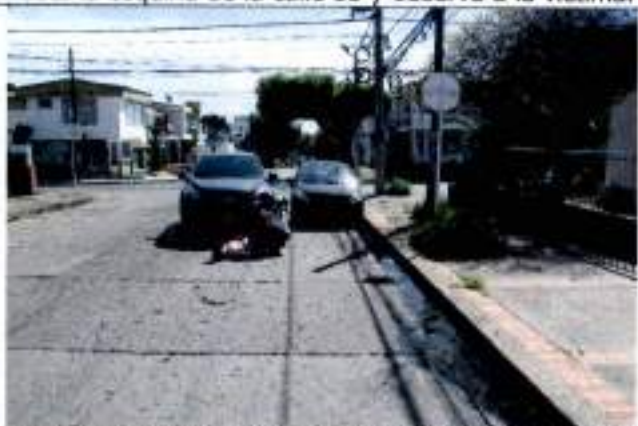
IMAGEN No.03. Se hace una panorámica del lugar para mostrar el estado de la vía y su entorno al momento de la diligencia.
