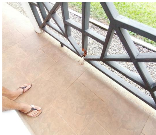
BARANDAS BLOQUE DE ALCOBAS
