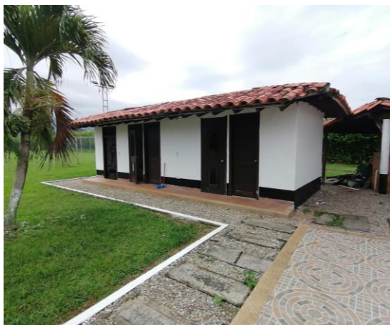
FACHADA SAUNA Y CARTO DE MAQUINAS
