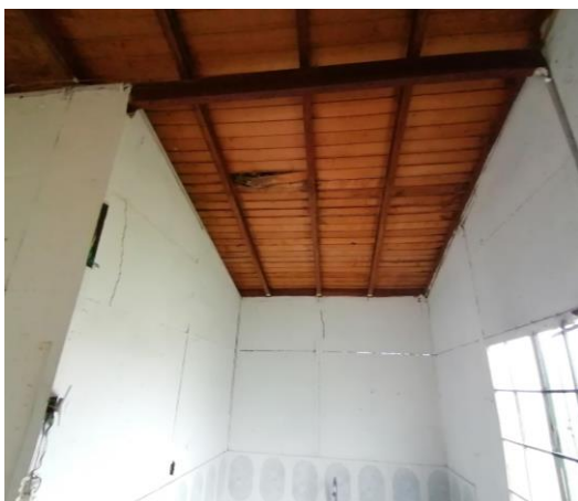
CIELO RASO CASA PREFABRICADA
