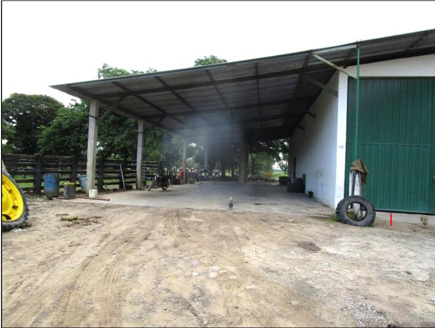
Enramada lateral en donde guardan la maquinaria; la línea roja indica el grosor del piso de la bodega, apropiado para soportar carga y evitar el ingreso del agua lluvia.
