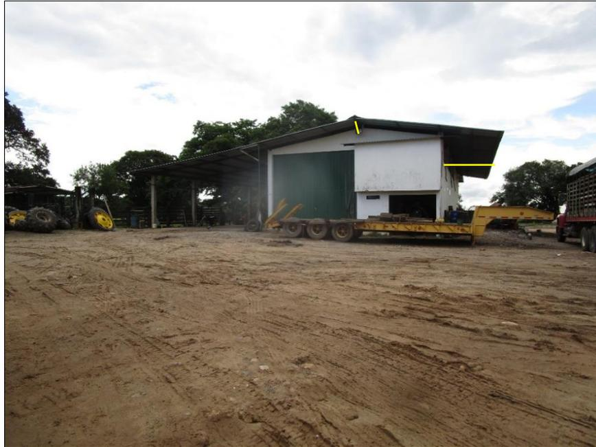
En esta fotografía se puede apreciar los voladizos del techo, para evitar que el agua lluvia penetre a la bodega, se resaltan con las líneas de color amarillo, también se observa el amplio portón de entrada
