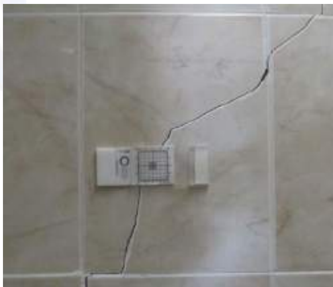
Imagen 54. Fisurómetros de monitoreo – FS#03
