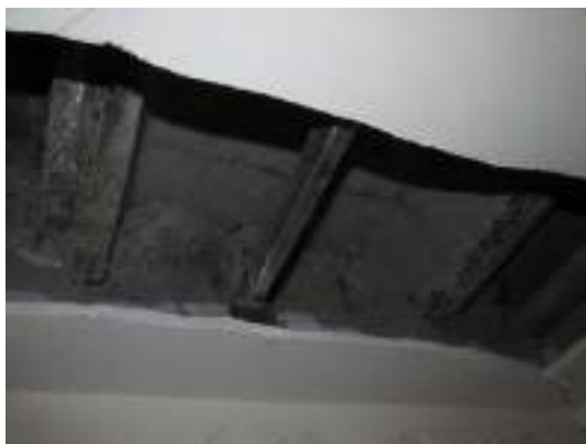
Imagen 49. Regata para inspección de refuerzo Losa entrepiso
