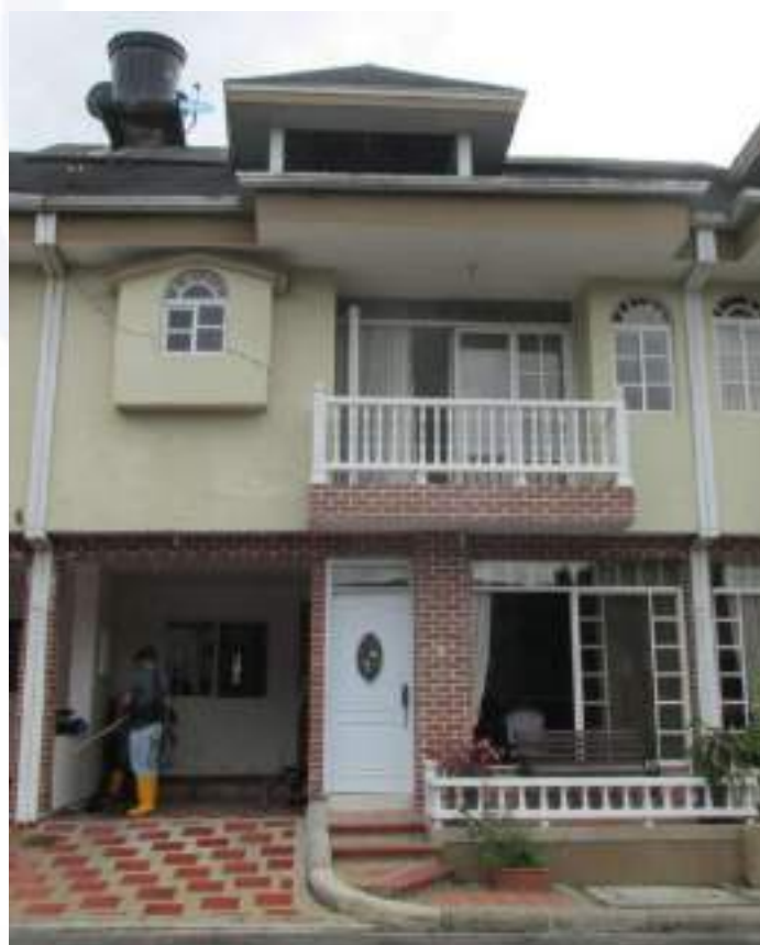
Imagen 3. Vista general de la edificación
