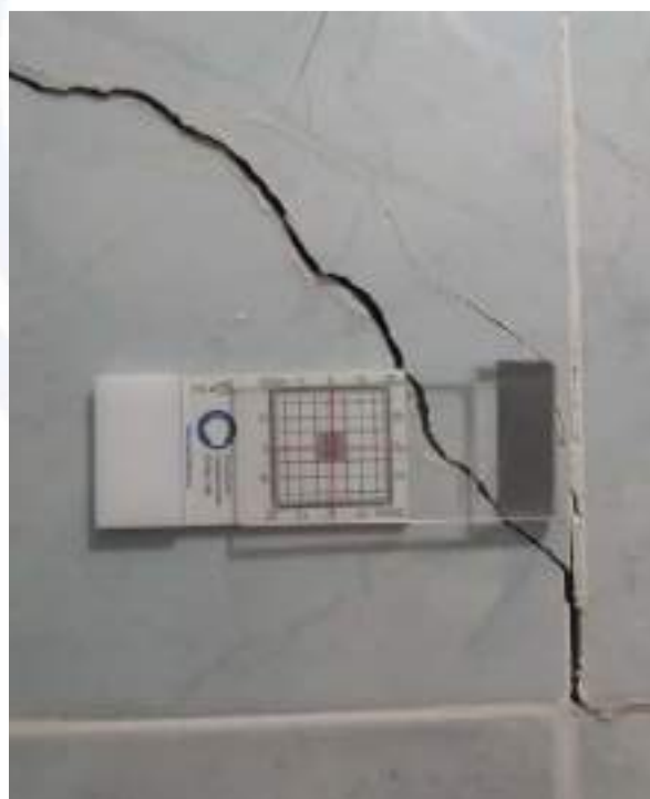
Imagen 56. Fisurómetros de monitoreo – FS#05
