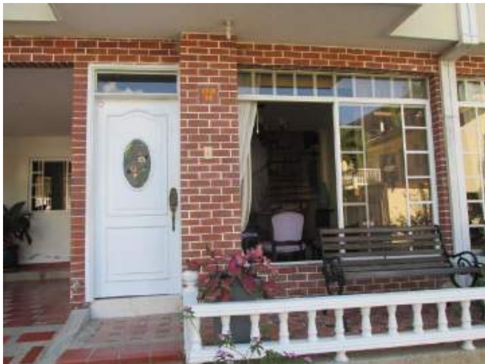
Imagen 4. Vista general de la edificación
