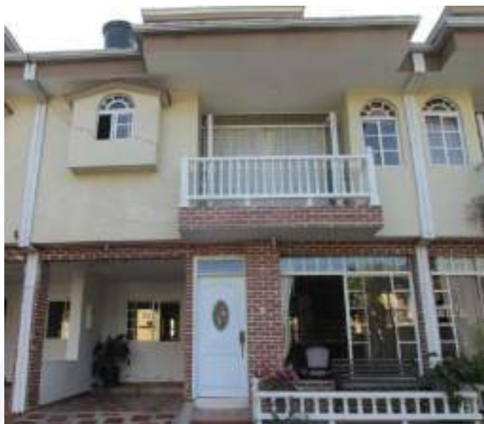
Imagen 2. Vista general de la edificación
