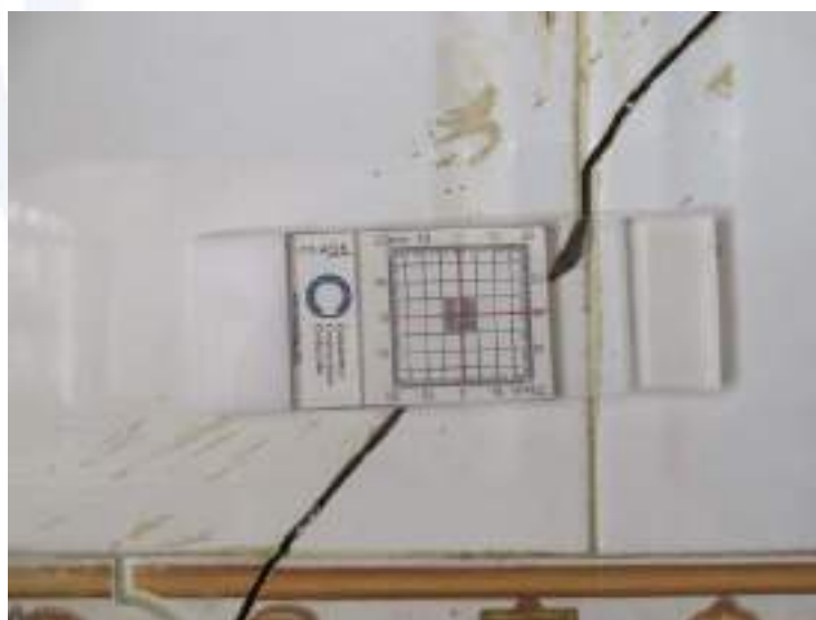
Imagen 52. Fisurómetros de monitoreo – FS#01
