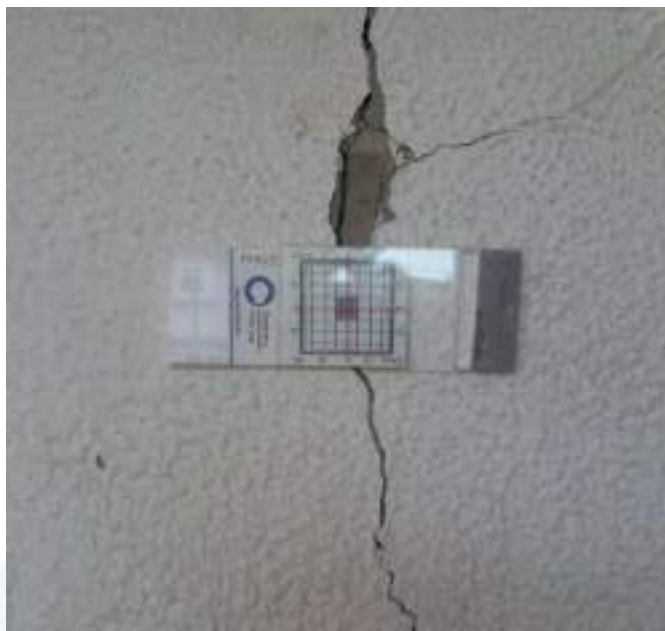
Imagen 55. Fisurómetros de monitoreo – FS#04
