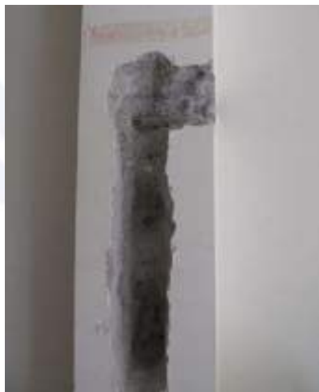
Imagen 48. Regata para inspección de refuerzo tipo Columneta.
