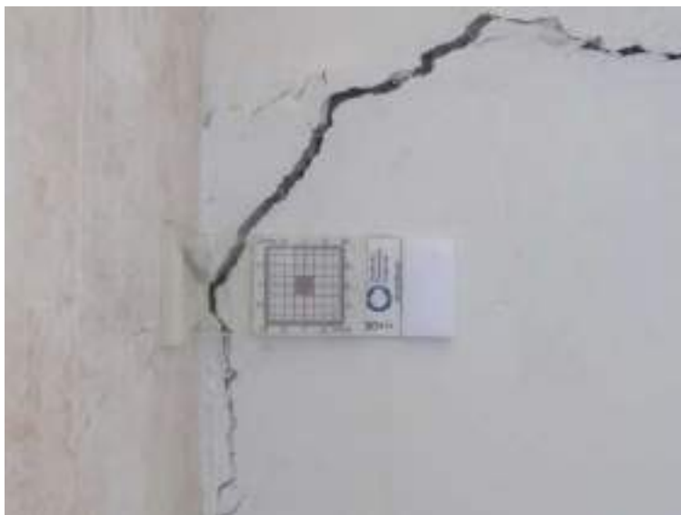
Imagen 53. Fisurómetros de monitoreo – FS#02
