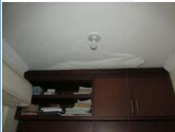
Imagen 36. Fisuras en unión mampostería L:25 cm e:1.2 mm.
