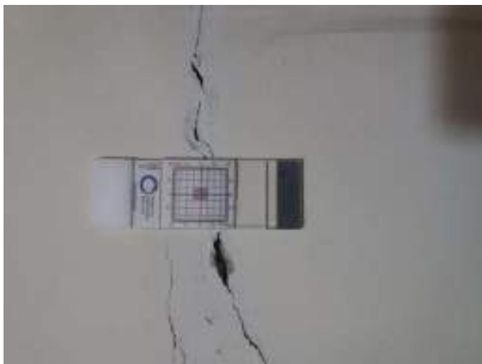
Imagen 57. Fisurómetros de monitoreo – FS#06
