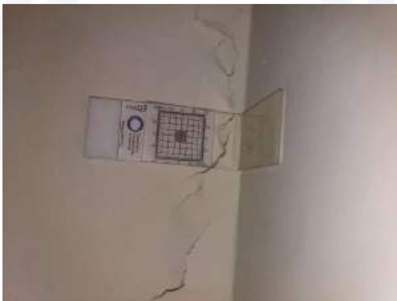
Imagen 1. Fisurómetros de monitoreo – FS#07
