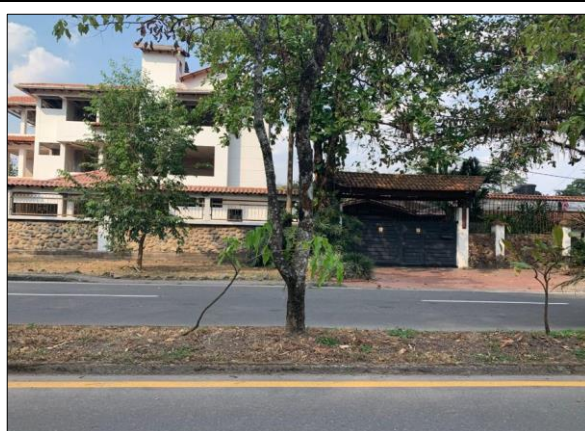
PANORAMICA FRENTE AL PREDIO
