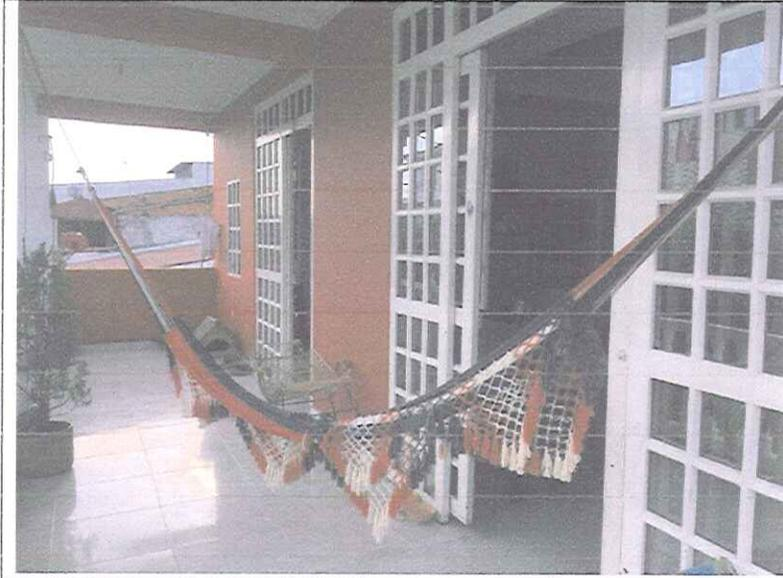
*Balcón: vigas y columnas en concreto reforzado pañetadas y pintadas, piso en cerámica, puertas y ventanas en aluminio con vidrio*
