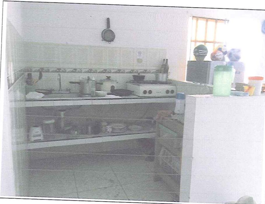
*Cocina: muros enchapados en tableta con cenefa, pisos en tableta. Mesón en concreto enchapado. Lavaplatos en aluminio.*
