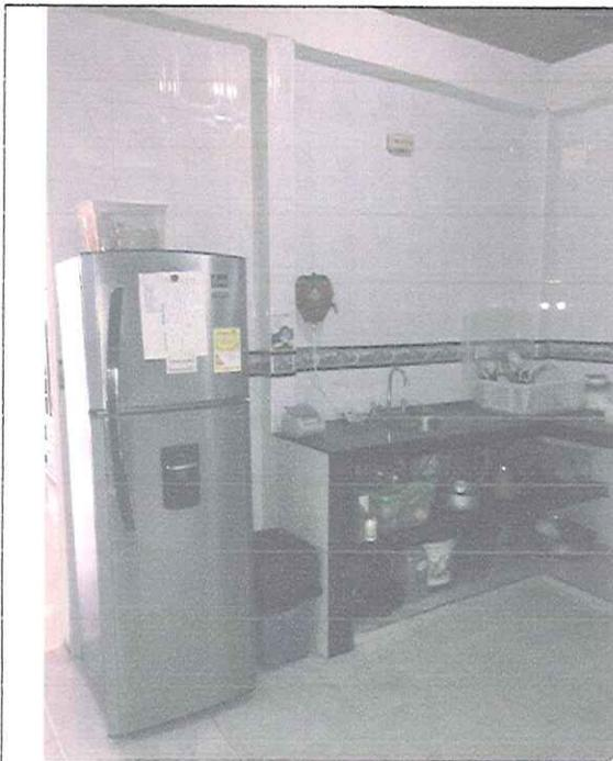
*Cocina: muros enchapados en tableta con cenefa, pisos en tableta. Mesón en concreto y enchapado con lavaplatos en aluminio, vigas y columnas en concreto reforzado pañetadas y pintadas.*
