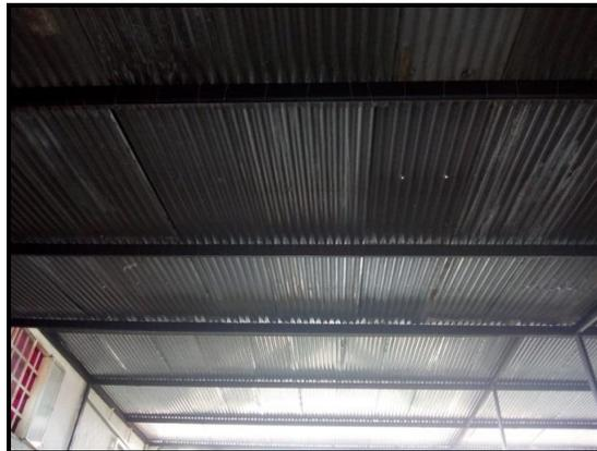
El techo es en teja de zinc soportado sobre una estructura en lámina metálica pintada en color negro. Este techo es más alto en la parte posterior del predio y tiene desnivel hacia la parte anterior o frente del predio.
