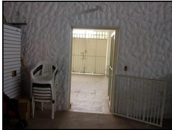
El piso es en cemento, concreto sin cobertura ni pintura. A mano izquierda entrando por la carrera 15 B se observa un a puerta angosta metálica pintada en color blanco con marco metálico que da el acceso hacia la vivienda.
