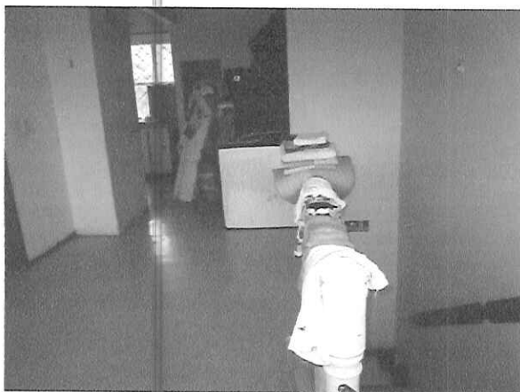
Hall en 3er piso
