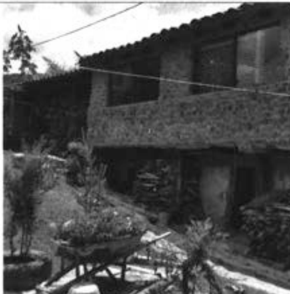
FACHADA 2da CASA
