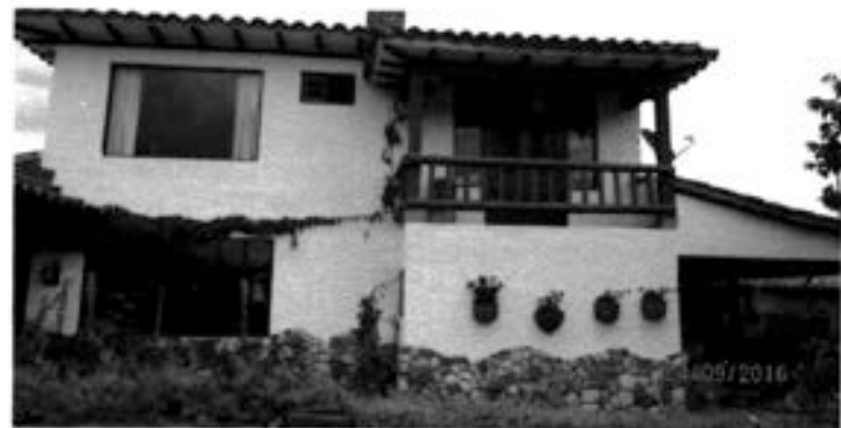
VISTA FACHADA LATERAL
