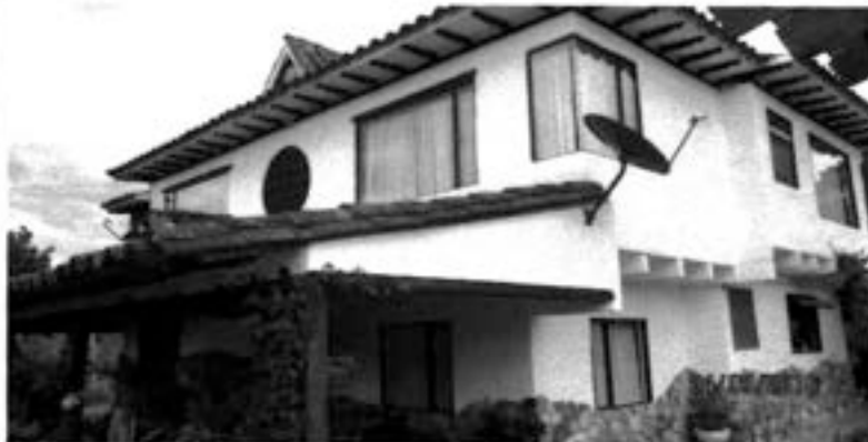
VISTA FACHADA POSTERIOR
