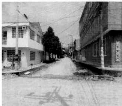
PANORAMICA ENTRADA AL BARRIO
