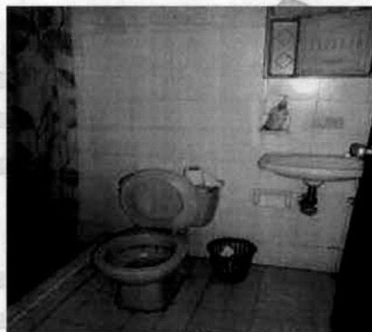
PANORAMICA BAÑO PRIMER PISO
