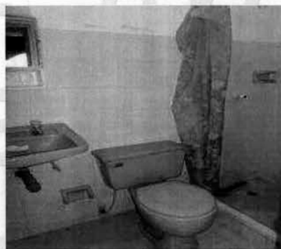
PANORAMICA BAÑO SEGUNDO PISO
