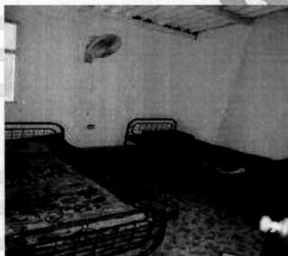
PANORAMICA ALCOBA SEGUNDO PISO
