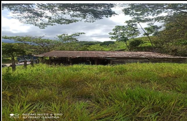
Registro de cubierta sobre corral construido en predio
