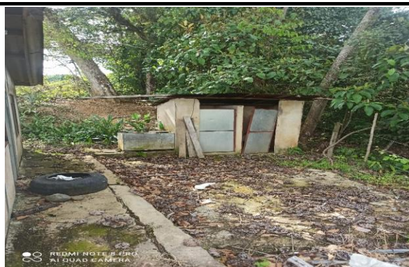
Construcción de baño
