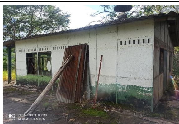
Edificación existente prefabricada
