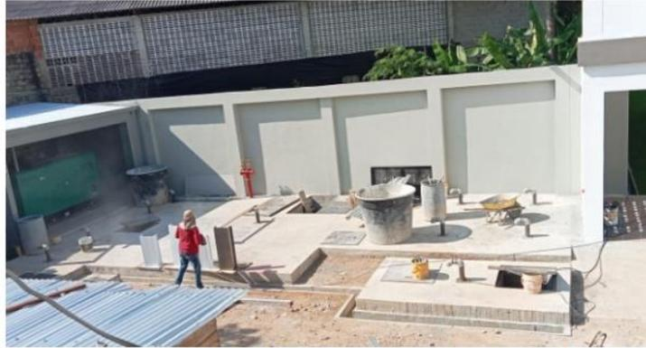
Registro Fotográfico: Construcción de tanque de almacenamiento para reúso de aguas lluvias.
